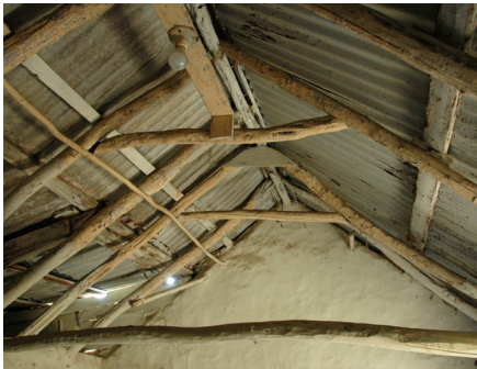
Figuur 8: Oude constructie Cunucubuis. Foto collectie Stichting Monumentenfonds Aruba.
